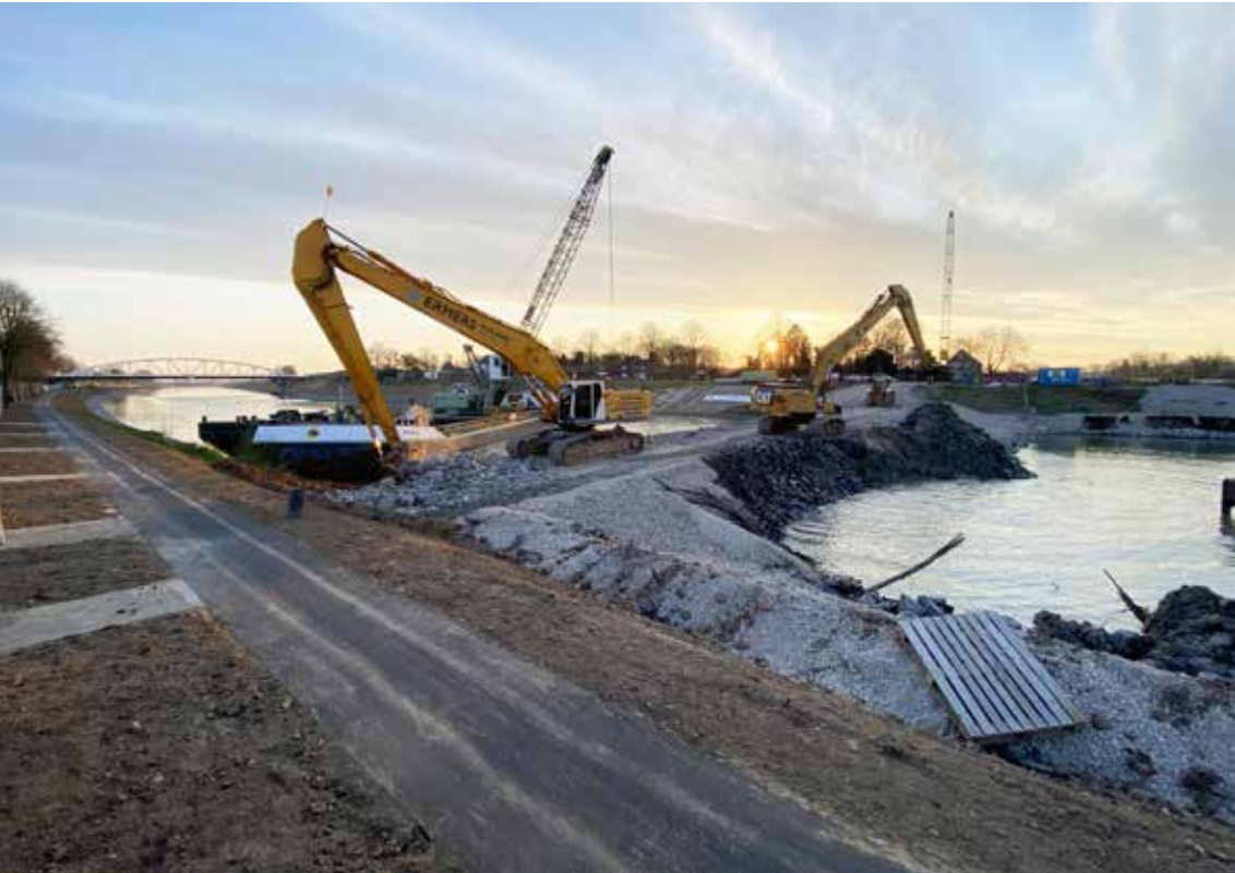
Donderdag 3 april werd begonnen met het afbreken van de dam. (foto Rijkswaterstaat)
